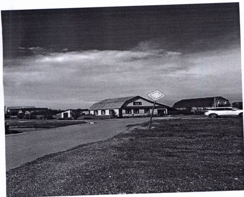
Рис. 5 пгт. Богатые Сабы, ул. Хазеева, д. 7 (выщел и поврежден знак)
