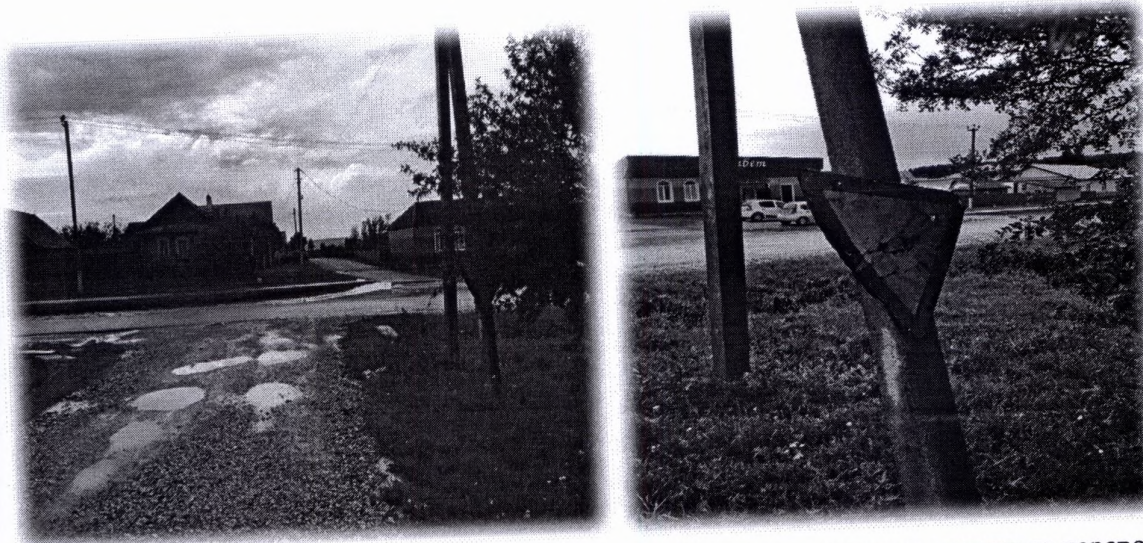
Рис. 6 с. Кильдебяк, ул. Мельничная, д. 42 ( Знак поврежден и перекрыт деревом)
